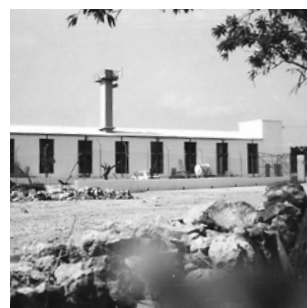
Fàbrica de Ca'n Blahi en construcció, 1970. Foto propietat Joan Serra.
